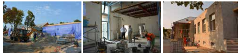
Rekonštrukcia bývalej zoborskej ZŠ na Dom kultúry
